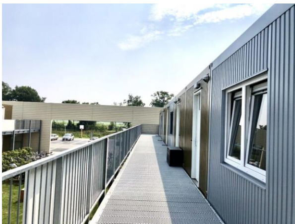
Voordeuren van de bovenwoningen in De Steiger in Zwolle
